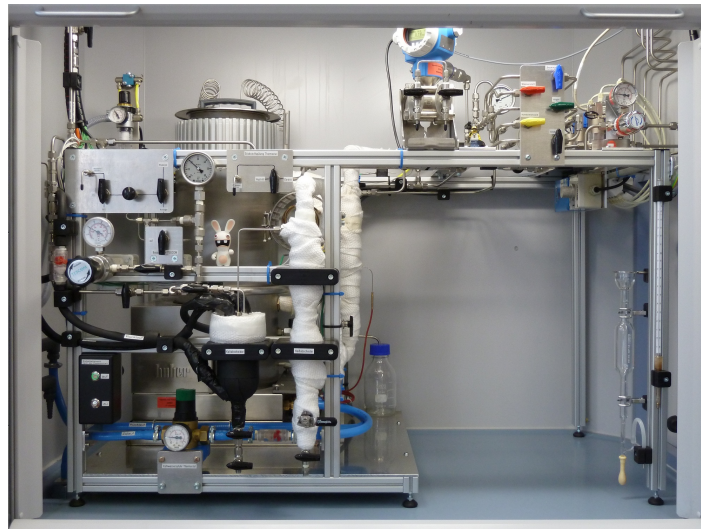
Abbildung 1: Neu errichtete eigenständige Versuchsanlage.
